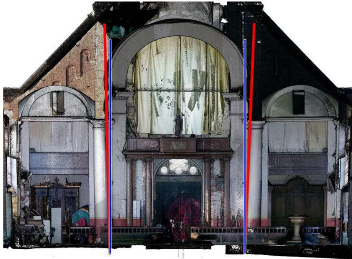
99 - En bleu : verticale depuis la base des piles ; en rouge : inclinaison réelle des piles, se déversant vers l'extérieur
