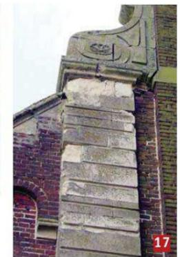
Il s'agit vraisemblablement d'un chemin d'eau qui a vidé les joints et permis au claveau pierre de descendre. Il conviendra de s'assurer qu'il ne s'agit pas d'un tassement en pied qui aurait fait éclater le piédroit appareillé Nord du portail.
