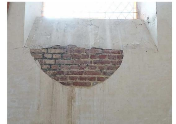
207 - Ruine de l'enduit sous l'appui de la baie de la dernière travée au Sud de la nef par les eaux de condensation en l'absence de bac récupérateur
