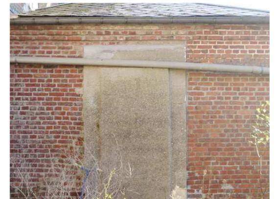
156 - Enduit au mortier de ciment pour combler une porte en élévation Ouest de la sacristie
