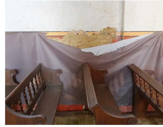
220 - Ruine de l'enduit de soubassement en élévation du bas-côté Nord, masqué par un drap
