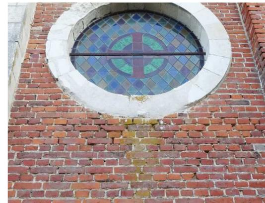
153 - Ragréage au mortier de ciment blanc de l'appui de l'oculus en 1ère travée du bas-côté Sud
