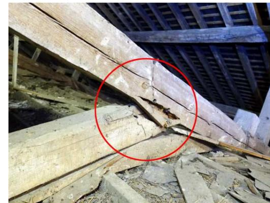
97 - Arrachement de l'assemblage tenon-mortaise de l'entrait retroussé de l'ancienne ferme de charpente (avant la rehausse de 1867). L'entrait retroussé ne triangule plus la charpente en partie haute ; elle est en appui sur les cerces du couverture
