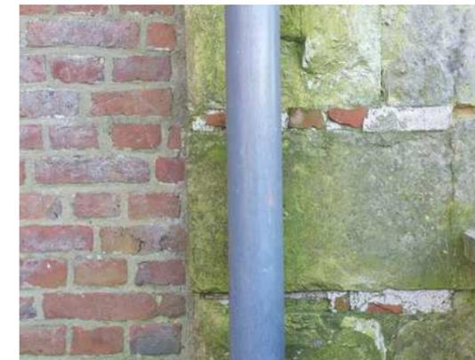
135 - Couverture par les algues vertes d'une maçonnerie de pierre lessivée par les eaux pluviales
