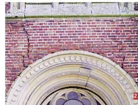
Il s'agit vraisemblablement d'un chemin d'eau qui a vidé les joints et permis au claveau pierre de descendre. Il conviendra de s'assurer, qu'il ne s'agit pas d'un tassement en pied qui aurait fait éclater le piédroit appareillé Nord du portail [photo 23].
