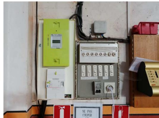
21 - Compteur Linky, coupure générale, et tableau de protection en deuxième travée du bas-côté Nord
