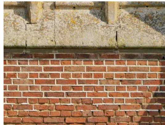
161 - Joints rubanés sous la verrière de l'élévation Ouest du clocher, protégés des intempéries
