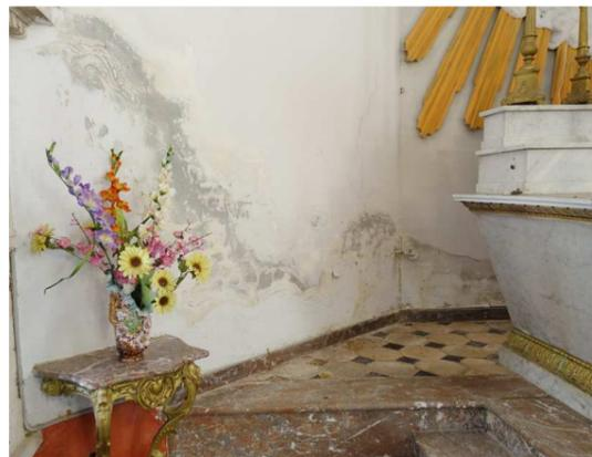
218 - Efflorescence en élévation du chevet
