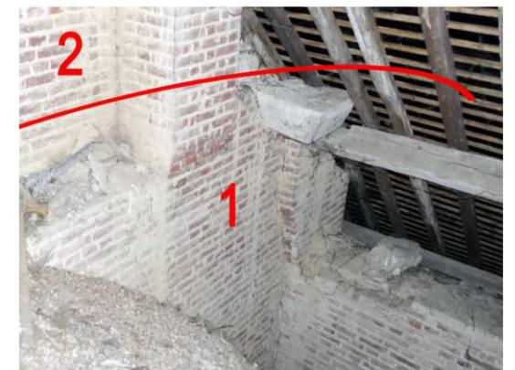
84 - Liaisonnement potentiellement pathogène des maçonneries, entre l'assise de l'ancien clocher (1) visible sur l'image de gauche, et le clocher de 1871 (2)
