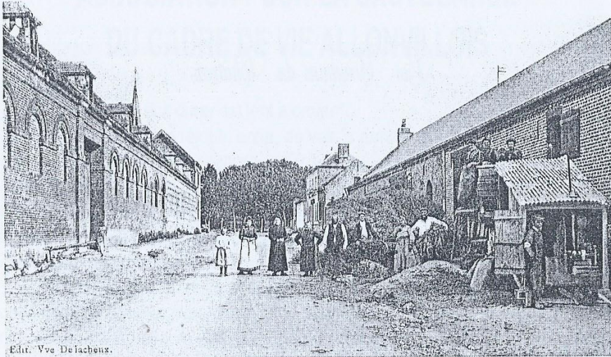
Rue des auges (en 1905). Sur les communs du château, on peut déjà y remarquer l'existence de lucarnes.
